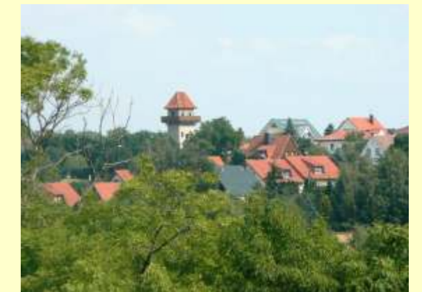
Wasserturm oberhalb von Alsleben
