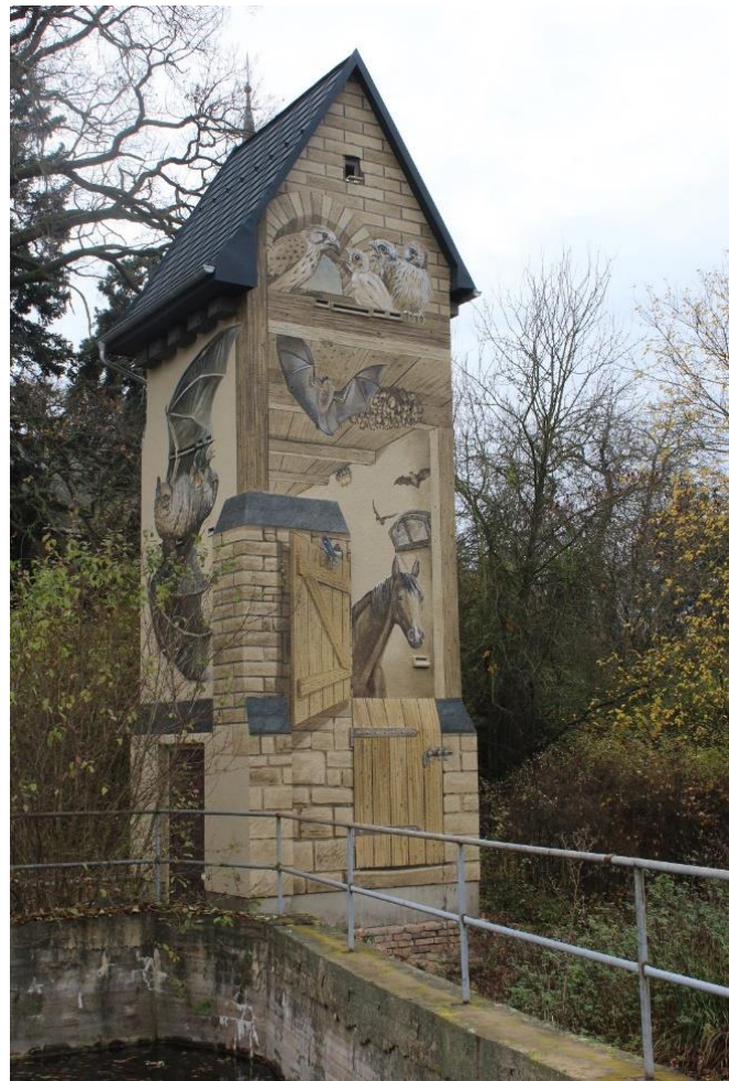
Umgebauter Trafoturm in Wils
